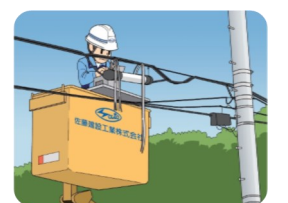
光ファイバー敷設
